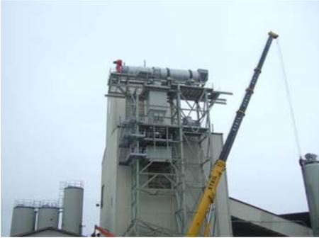
Paralleltrommel mit Heißgaserzeuger (Gegenstromprinzip)
