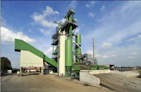
Zugabe von selektiertem Asphaltgranulat über 4 separate Doseure
