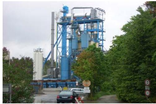
Asphaltmischanlage mit Paralleltrommel
